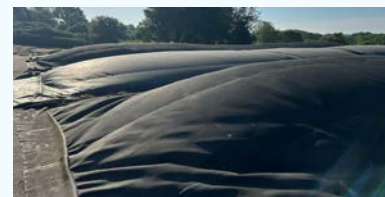
Figure 8 – Digesteurs de méthanisation
