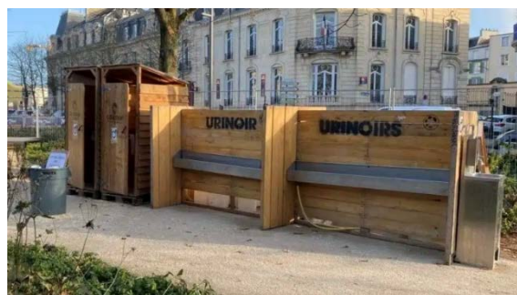
Figure 1 - Cabine de toilettes sèches et urinoirs masculins (crédit : ginkoop.coop)
