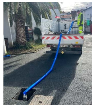
Figure 4 - Transfert des urines entre le collège et la cuve du camion (crédit : Civam blé)
