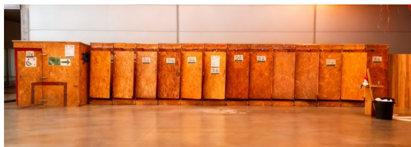
Figure 3 - Cabine de toilettes sèches (crédit : ecosmose.fr)
