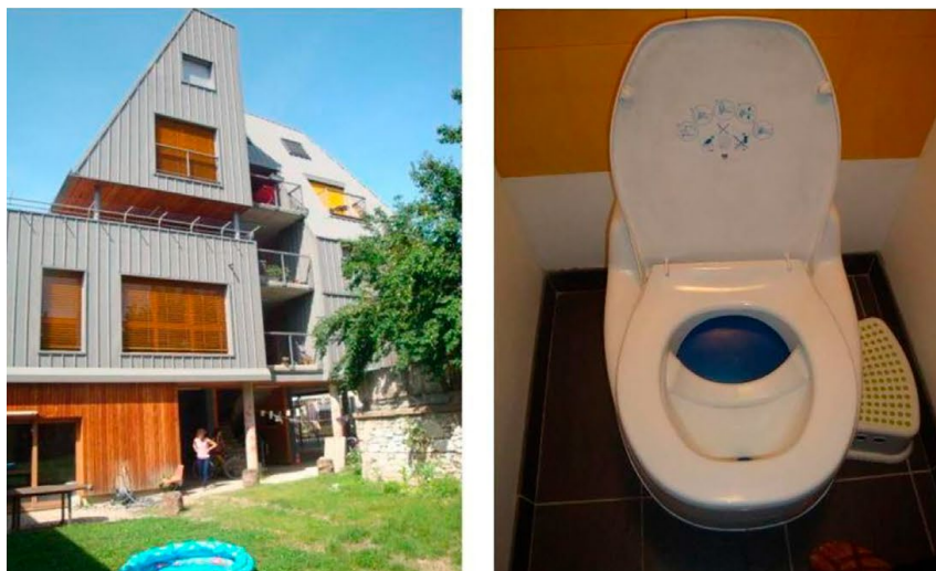
Figure 13 : Logement collectif du quartier Au Claire à Grenoble et toilettes sèches séparatives des 5 appartements concernés
