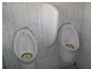
Siphon à cartouche (à étanchéité liquide)
